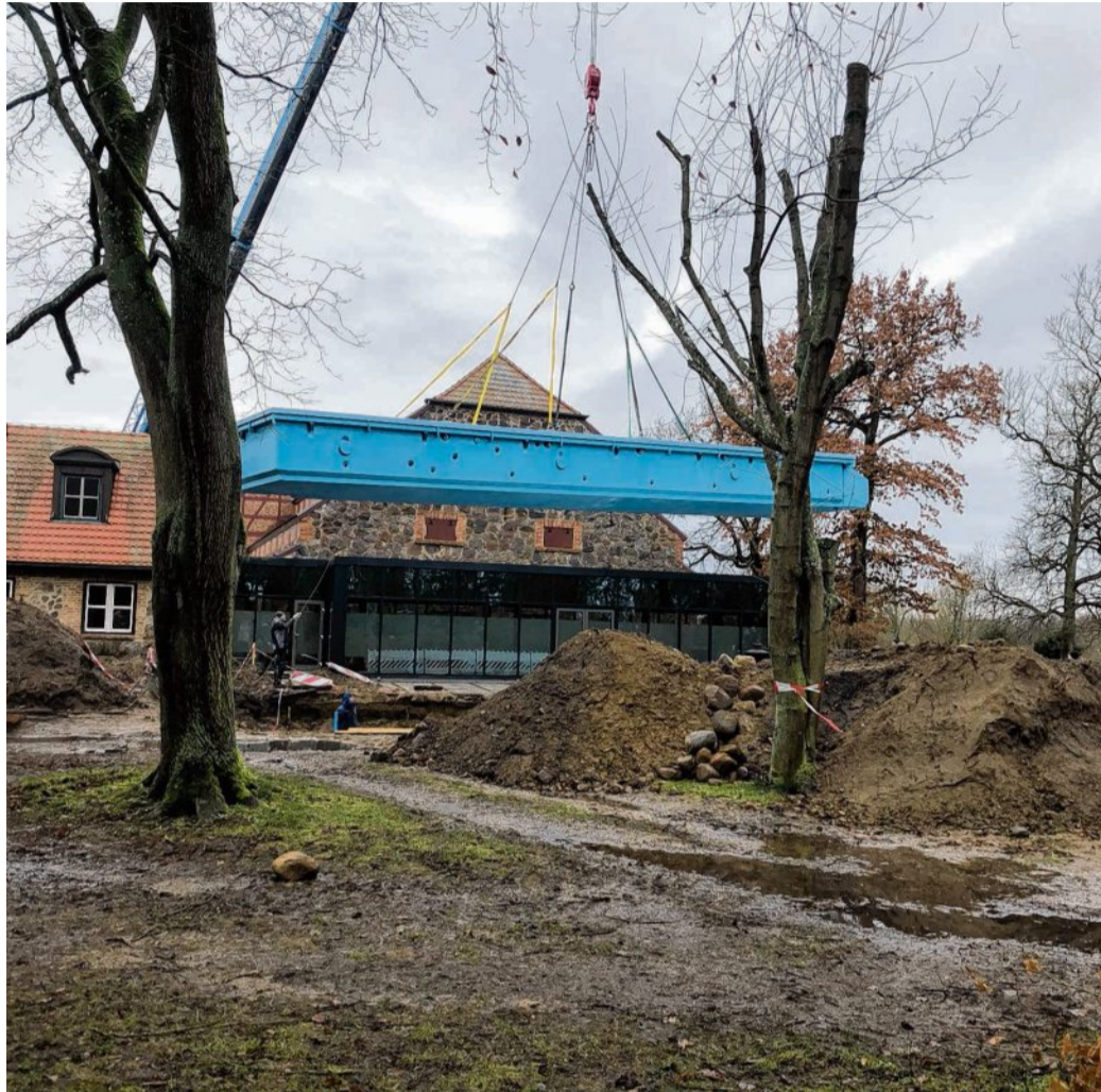
Von einem riesigen mobilen Schwerlastenkran wurde das Schwimmbecken über das Dach des ehemaligen Pferdestalls an seinen künftigen Standort im Gutspark gehoben. FOTO: ZVG/GUTSHAUS STOLPE
