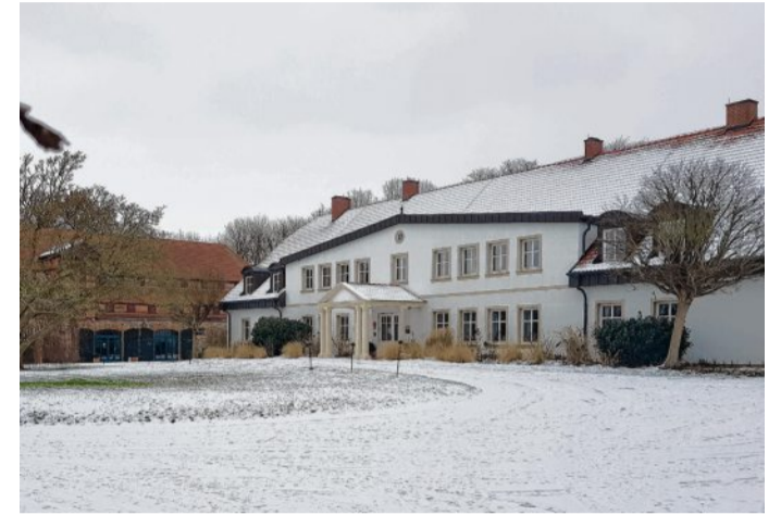
Das Gutshaus in Stolpe liegt momentan im doppelten Winterschlaf. Zum einen ist der Hotelbetrieb wegen des Lockdowns eingestellt, zum anderen legt das Team in den Wintermonaten aber auch regelmäßig eine Pause für Renovierungs- und Bauarbeiten ein.
